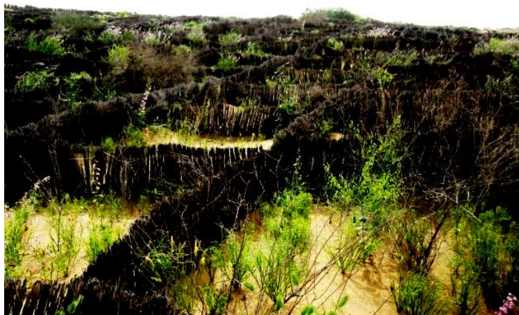
Рисунок 1 – Укоренившаяся растительность в механических защитах вдоль железной дороги
