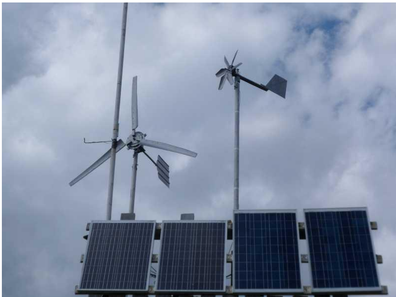
Рисунок 16 – Горизонтальный ветрогенератор
