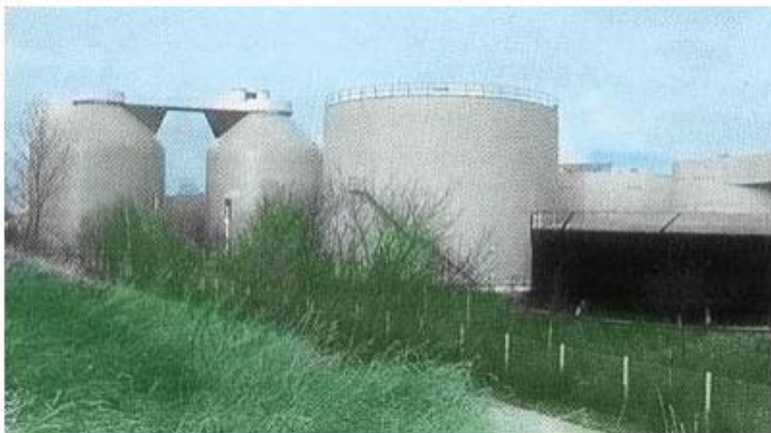
Рисунок 14 – Коммунальная биогазовая установка (анаэробный этап очистного сооружения)
