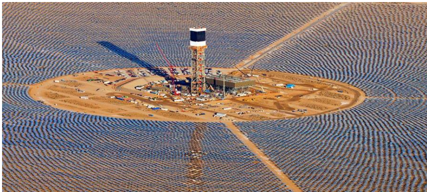
1.21 сурет – Мұнара түріндегі күн электр станциясының схемасы
