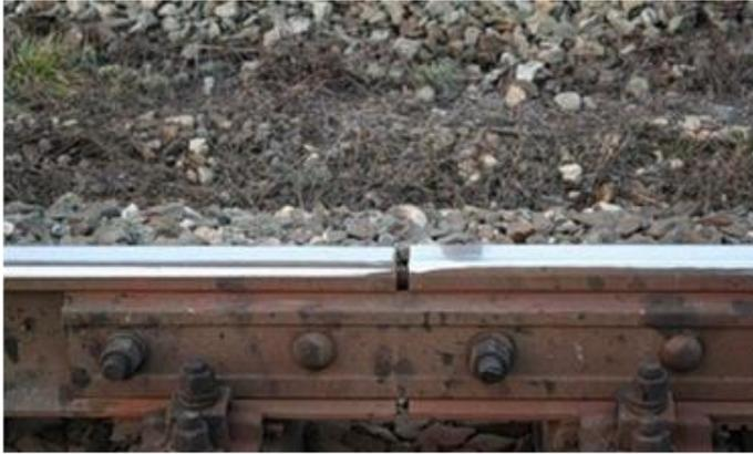
Рисунок 12.2.– Тепловой зазор между рельсами железной дороги
